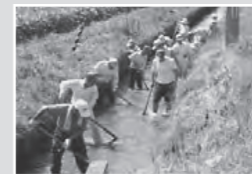
水路の泥上げ
