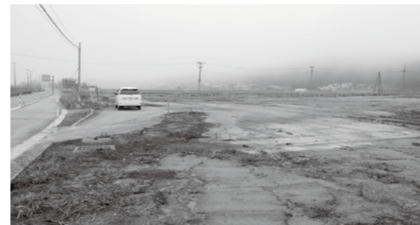
解体工事が完了し造成前の旧大豊小跡地
